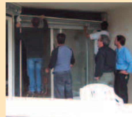
Réhabilitation "Les Salamandres" : les techniciens s'attèlent à l'installation de volets roulants
