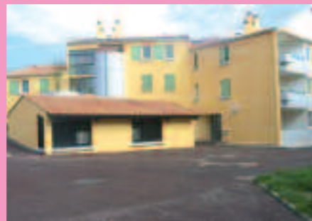
"Les Salamandres" après réhabilitation
