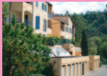
"Les Pivoines" après réhabilitation
